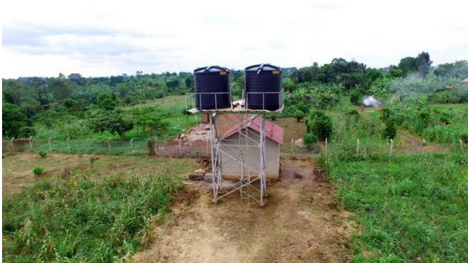
Stromversorgung über ein Photovoltaikpanel reichte nicht aus. Die Pumpe wird mittlerweile mit Strom aus dem öffentlichen Netz betrieben. Seit gut einem Jahr sind bisher 139 m<sup>3</sup> gefördert worden. Um mehr Häuser an das Netz anzuschließen wird überlegt, als Anreiz kostenlose Anschlüsse mit einem kostenlosen Volumen von 2 m<sup>3</sup> zur Verfügung zu stellen.
